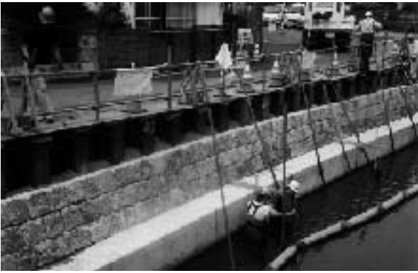
▶再生された銚子石護岸
